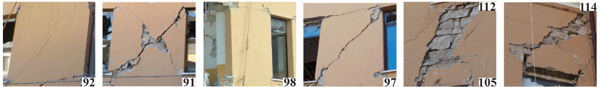
Edificio complesso - Caso C - Parete 8 - PT
