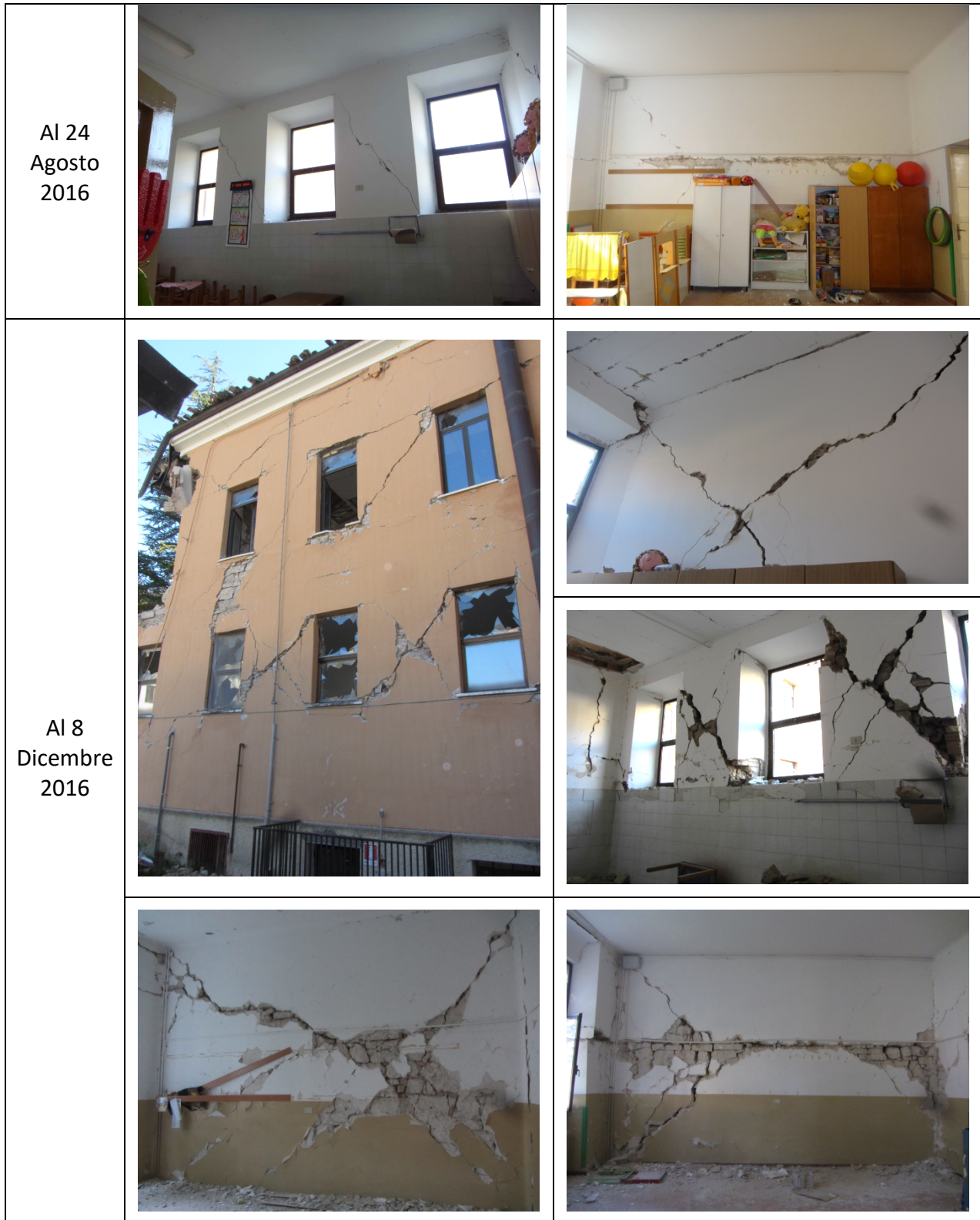
Figura 4 – Ulteriori immagini relative al danno occorso nella Scuola “P. Capuzi” di Visso (MC) che documentano l’attivazione di una risposta prevalente nel piano delle pareti (sia esterne che interne)
