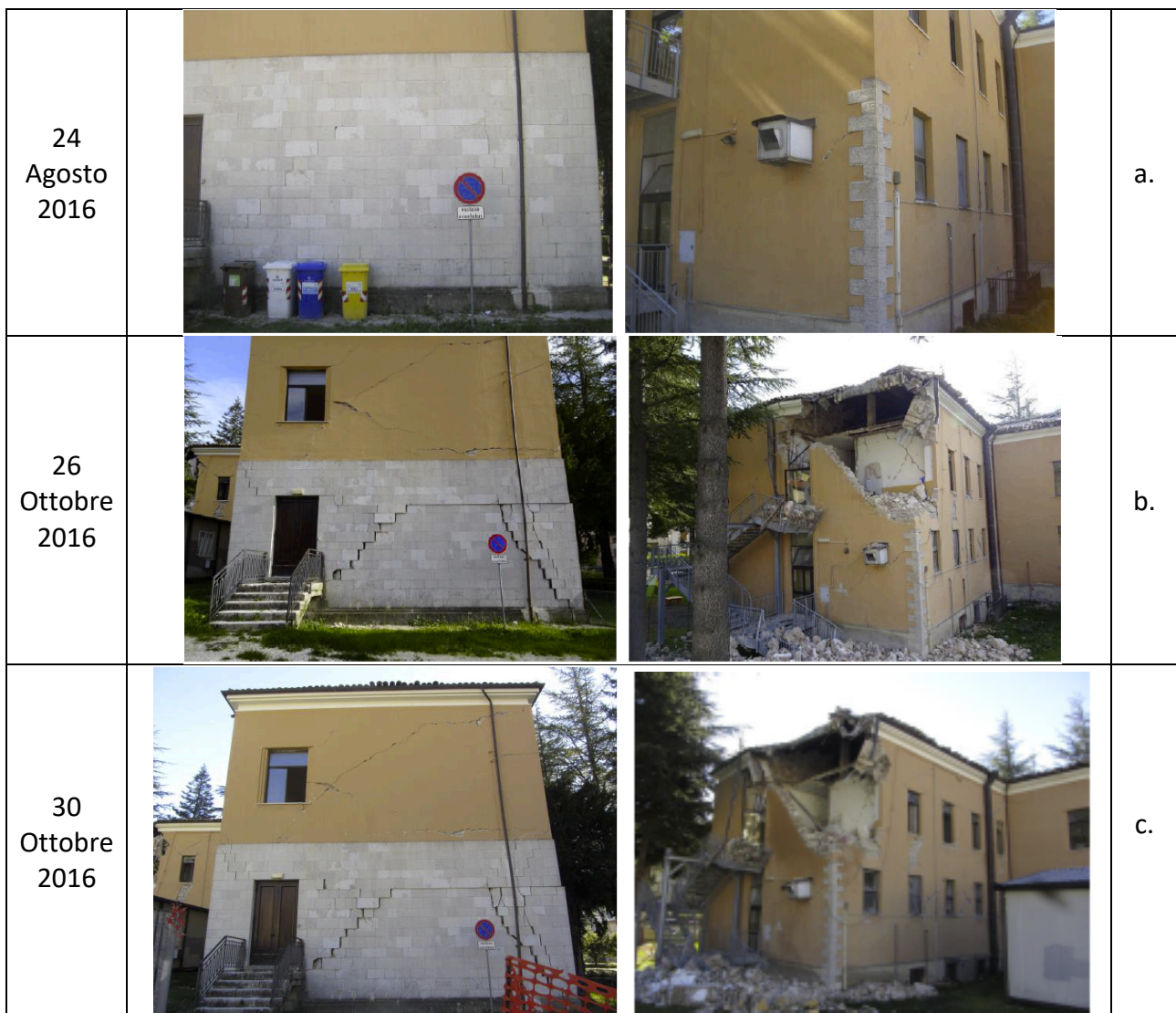
Figura 3 – Rilievo del danno della Scuola “P. Capuzi” di Visso (MC) a seguito delle scosse del 24 Agosto (a), 26 Ottobre (b) e 30 Ottobre 2016 (c) del terremoto in Centro Italia 2016/2017. Si evidenzia come l’attivazione del meccanismo locale abbia interessato una porzione limitata della struttura e sia occorsa a seguito della scossa del 26 Ottobre 2016 (presumibilmente la seconda più significativa avvenuta in tale data)
