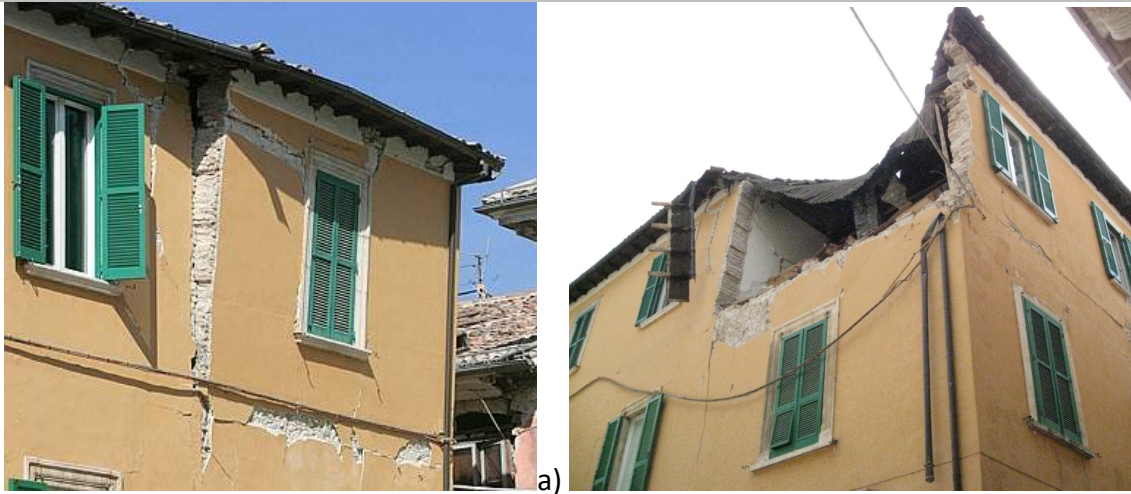
Figura 1 – Esempio di meccanismo “locale” tratto dal terremoto de l’Aquila 2009 associato alla risposta delle pareti murarie per azioni prevalenti perpendicolari al loro piano medio (a) attivazione e rotazione visibile alla base del blocco; b) completo collasso della porzione muraria
